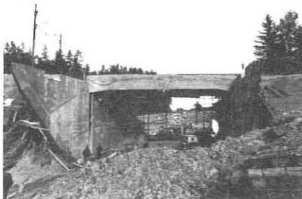
Kulverten på plass under jernbanen.
