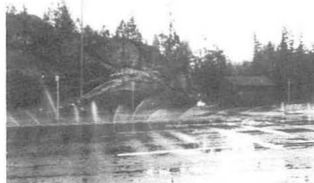
Overrislingsanlegget i full virksomhet.
