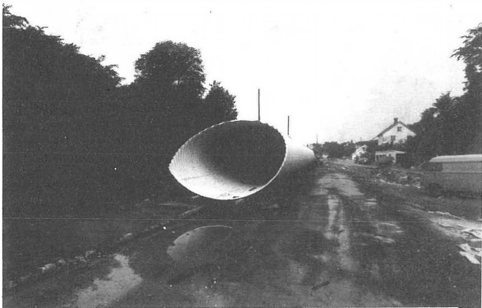
Monteringen av halve røret foregikk langs Rv. 410 Kjørestranda—Barbu.
