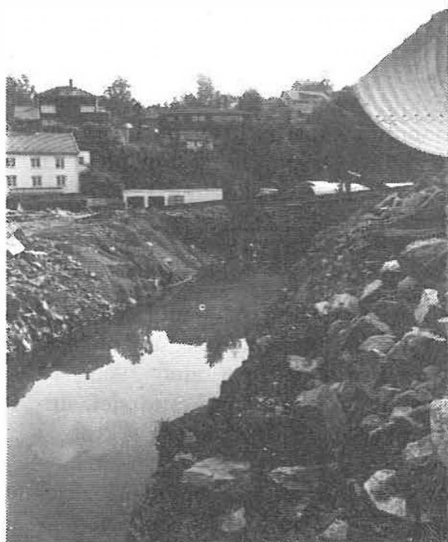
Den gamle Langsæ bru er fjernet, og nytt løp lagt ferdig.
