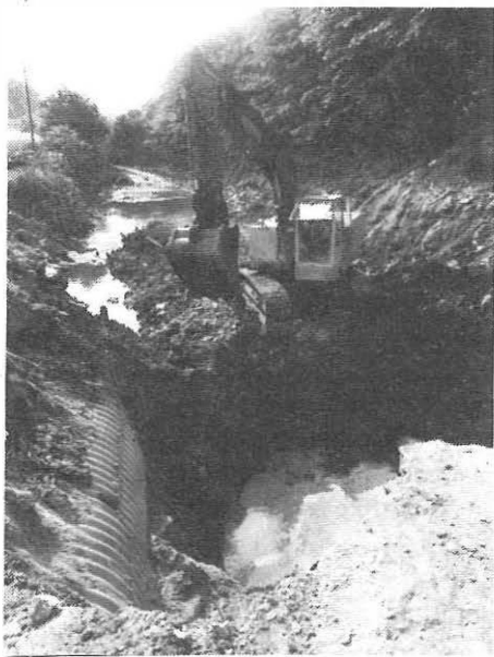
Omfattende gravings-/planeringsarbeider måtte til i Barbuelva.
