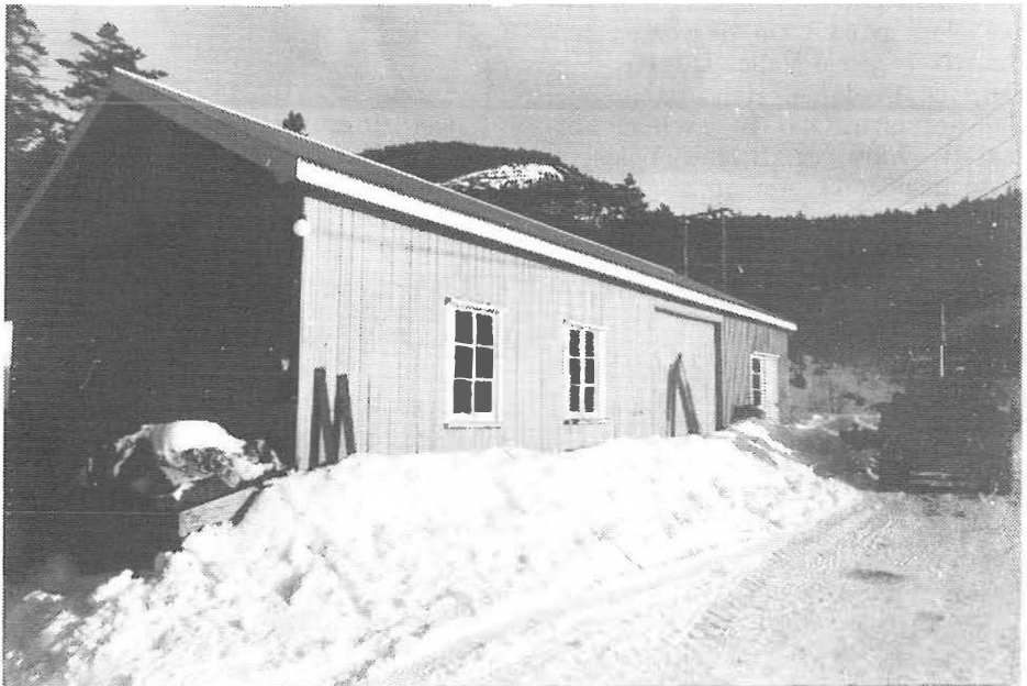
Nesmoen, verksted og lagerbygg.
