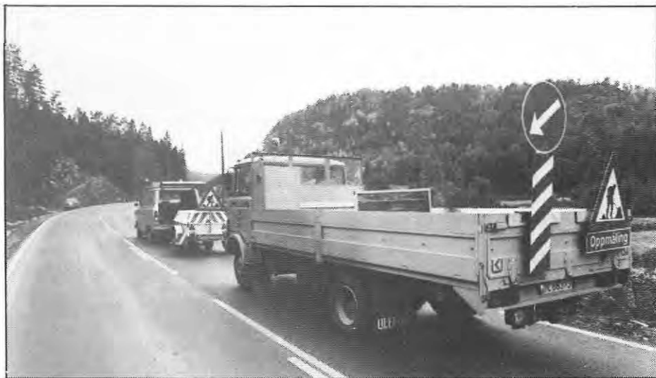
På sterkt trafikkerte veier er det meget viktig å ha med sikringsbil.
