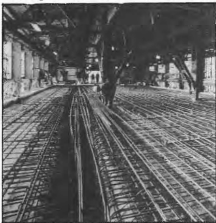
Total armeringsmengde i brua var 7000 tonn og betongvolumet var 105 000 m 3 .
