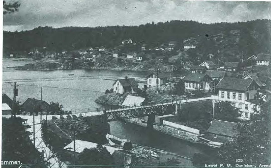
Strømmen bro, ferdig bygget i 1878, var den første fagverksbro i landet. Den hadde en spennvidde på 19,80 meter.
