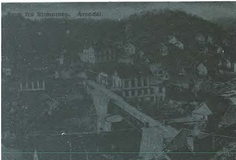
Strømmen bro var på fastlandssiden festet til en vertikal aksel, og var lagt på ei dreieskive.
