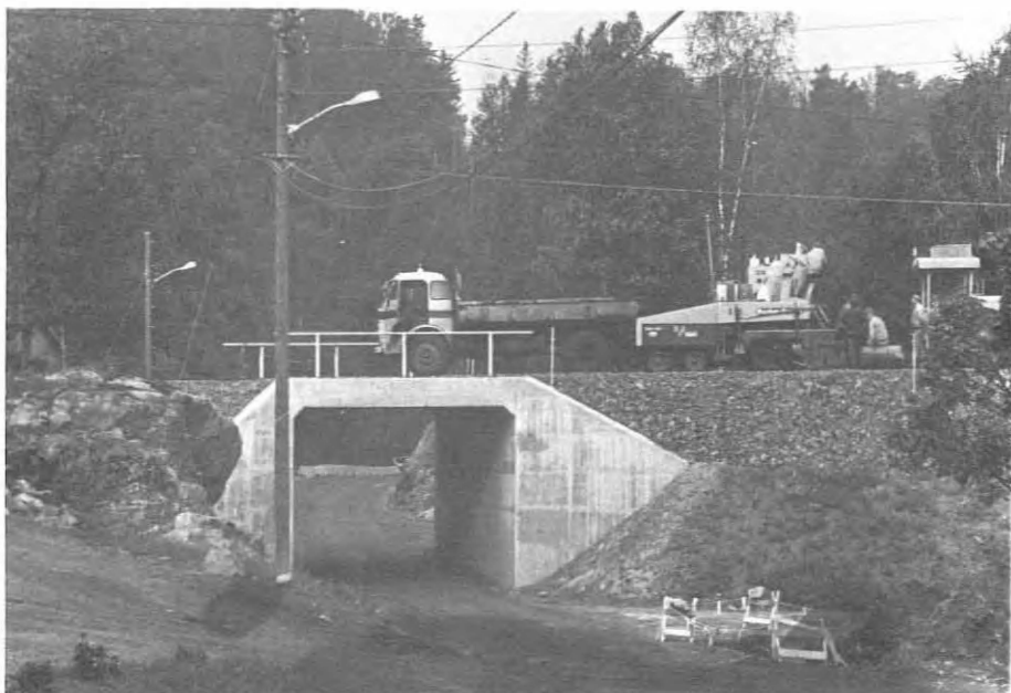
E18 går med kulvert over fv. til Myra. Bredde 5,0 m, høyde 4,0 meter.
