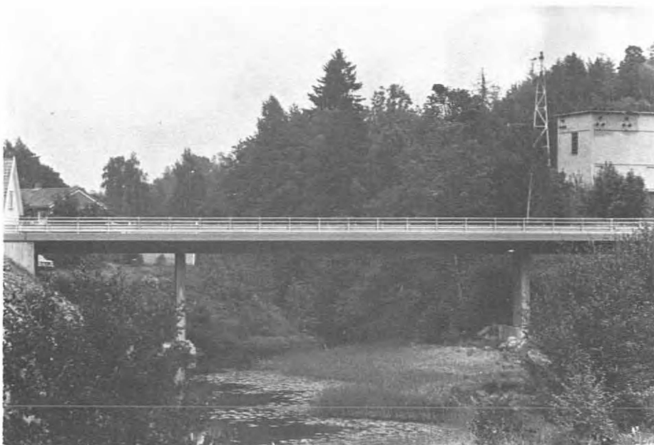
Katthølen bru over Rånakanalen, spenn på 10,0 + 24,0 + 10,0 m, total bredde 10,8 meter.
