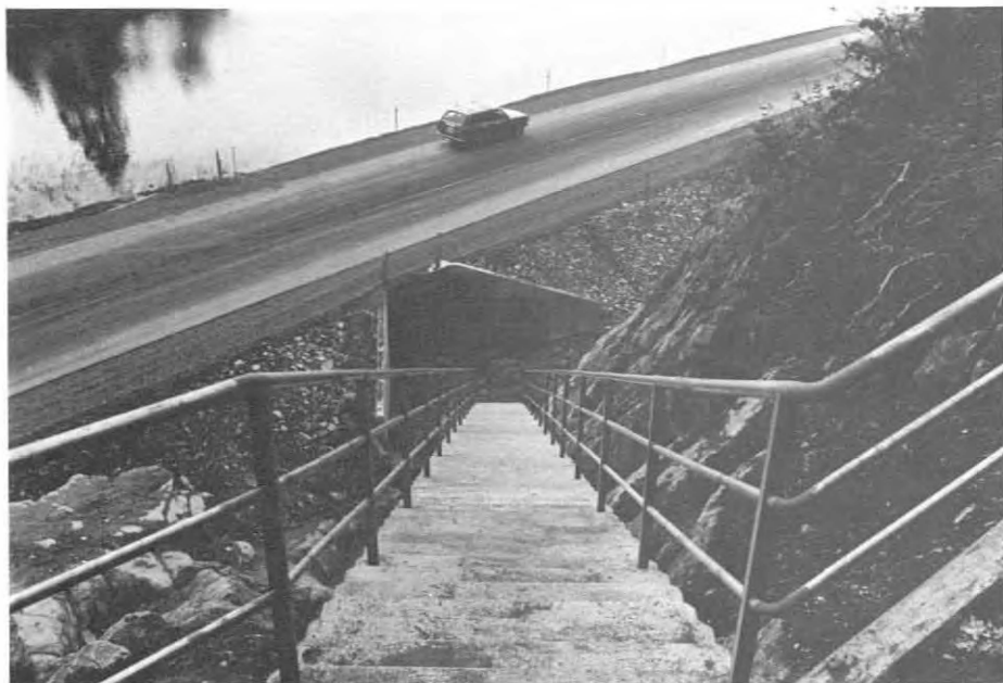
77 trappetrinn og en kulvert under E18 sørger for at oppsitterne kommer trygt frem til Longumvannet.
