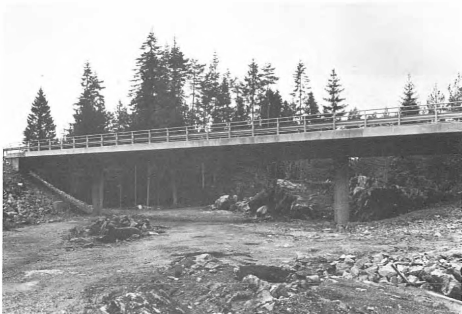
Selde bru med spenn på 15,0 + 25,8 + 15 m, bredde fra 6,8—7,8 m.
