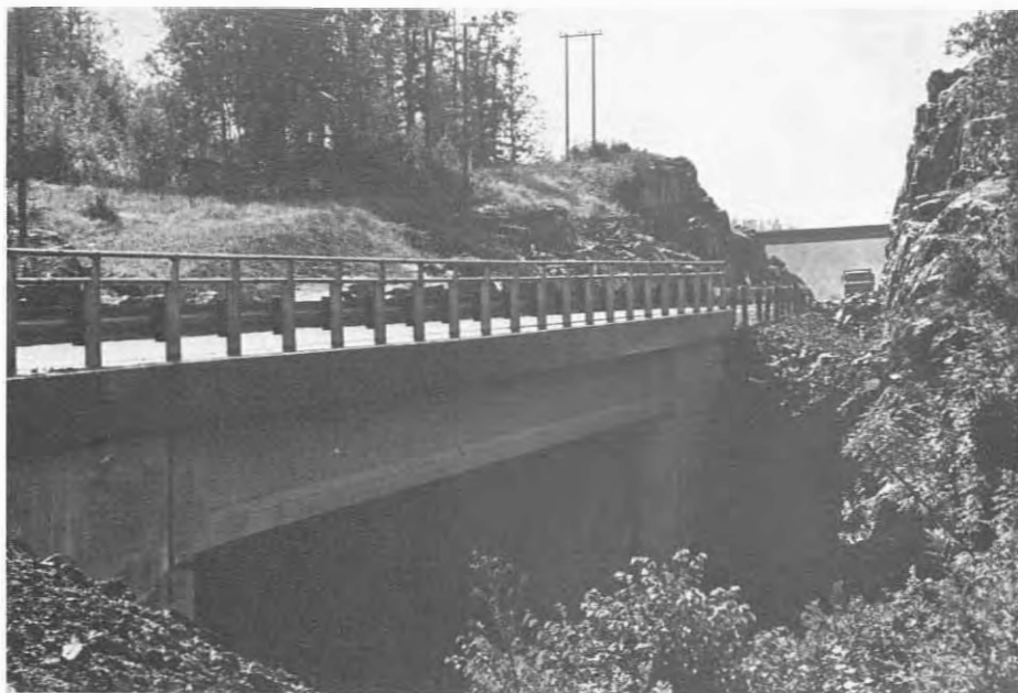
Sandbekkdalen bru, 30,0 m i et spenn, bredde totalt 16,5 m. T. h. Åsbie gangbru, lengde 22,2 m, bredde 3,6 m.
