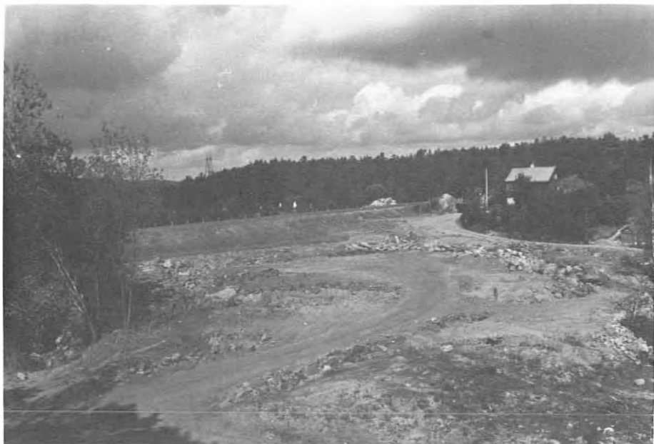
Over Sprokilen er vegen lagt på en ca. 20 m høy fylling fra bunnen av vannet.
