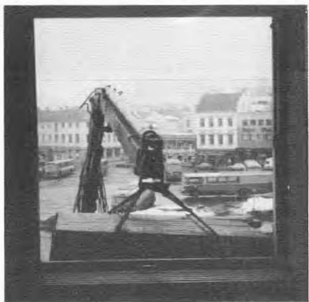
Og her kommer den inn vinduet i 3. etasje.
