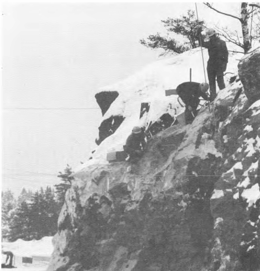
Arbeidene med gang/sykkelveg Vippha - Nedenes fortsetter.
