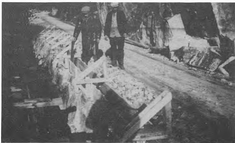
Fra arbeidene med støping av fenderkanter, Fånefjell.
