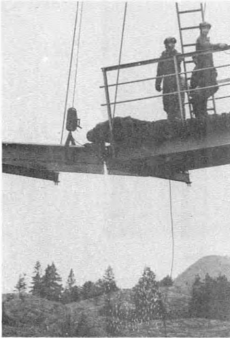
Skjærebrenneren i hendene på L.O. Knutson sørger for at en ny del av brua kan demonteres.
