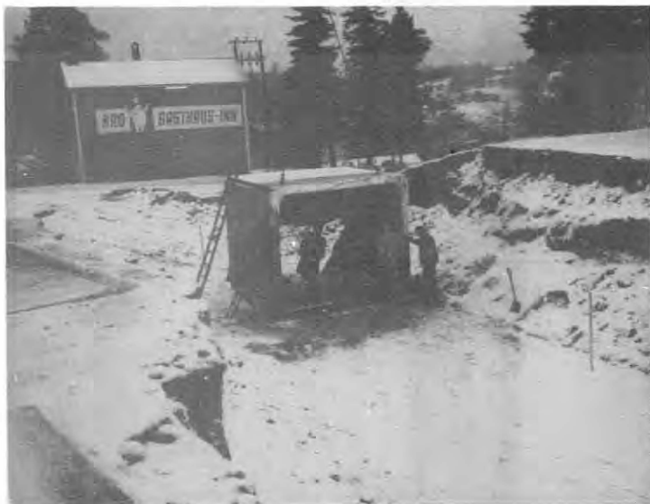
Det første elementet på plass "under" rv. 12.
