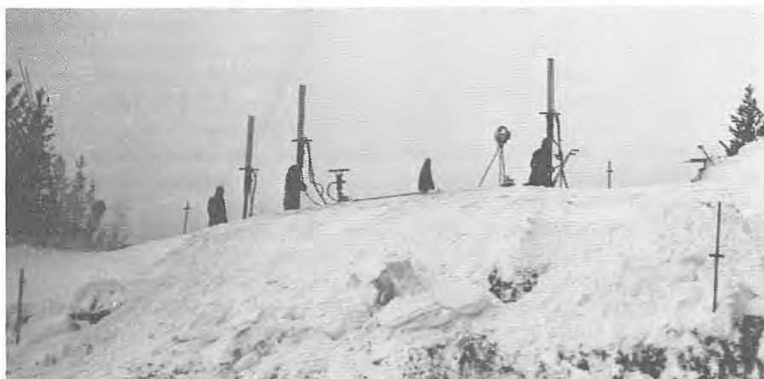
Som nakne trestammer reiser bormaskinene seg mot vinterhimmelen.
