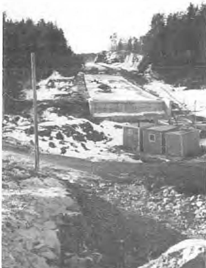
Vestre Solberg bru er ferdig.
