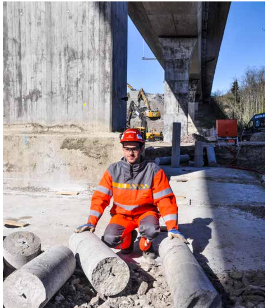
NYE PELER MÅ TIL: Kontrollingeniør Kjell-Einar Asmyhr viser frem noen av de utborede betongkjernene fra fundamentene. I hullene skal det støpes nye peler for å bære brua.
