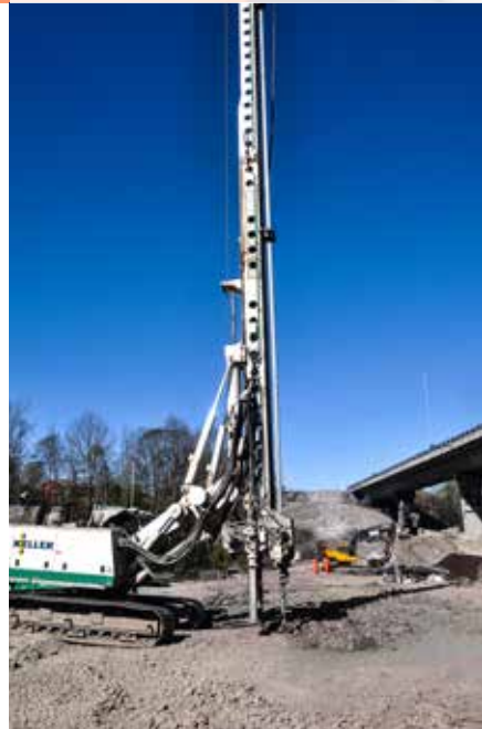
OMRÅDESTABILISERING: 70.000 meter kalksementpeler støpes i grunnen inntil brufundamentene ved hjelp av en spesiell boremaskin som visper kalksement sammen med leira i lange striper. ▼
