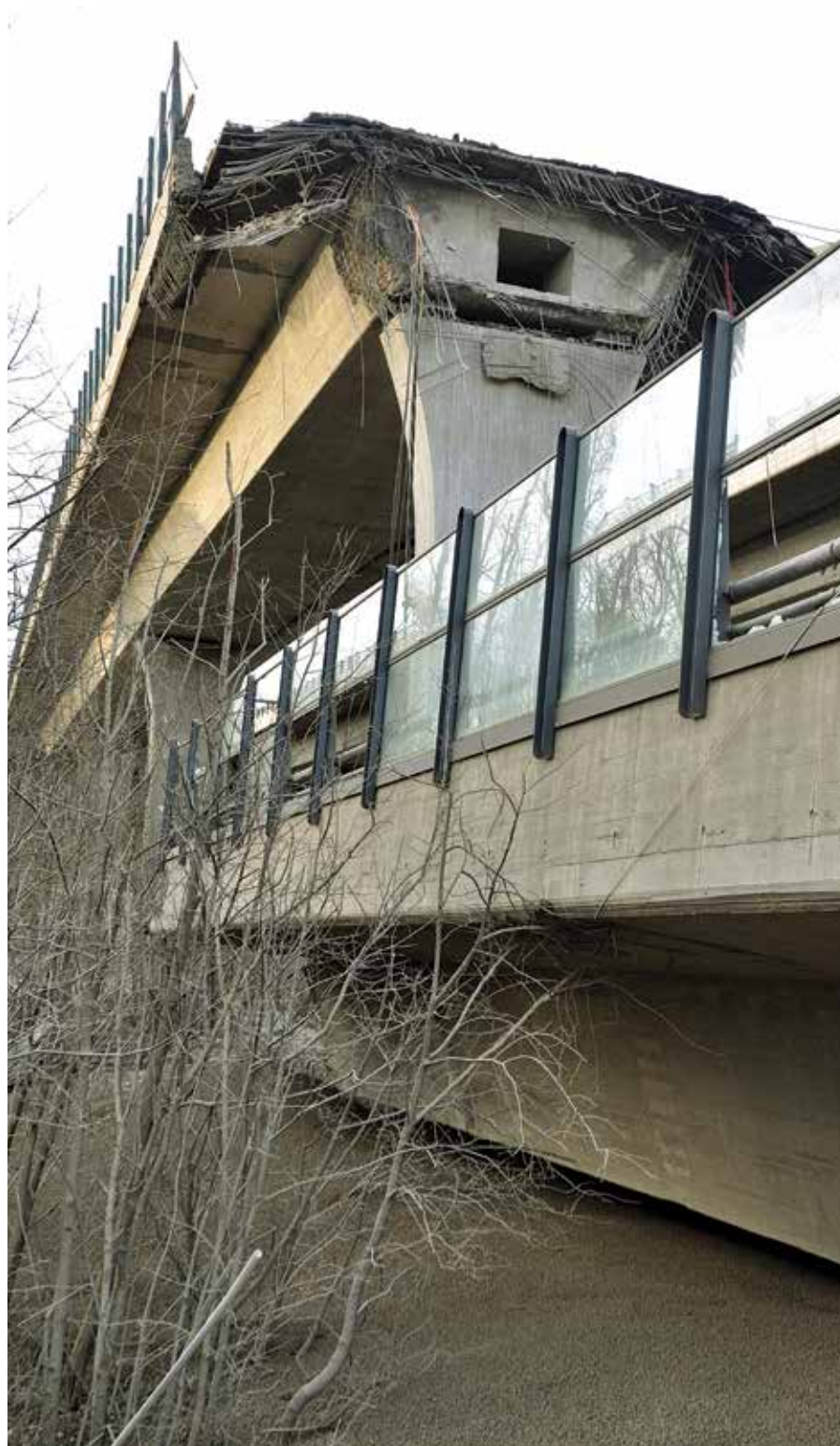
BORTENÅ: Det lot seg ikke gjøre å gjenbruke den nordlige delen av Skjeggstad bru. Nå er også denne sprengt ned og så starter gjenoppbyggingen.
