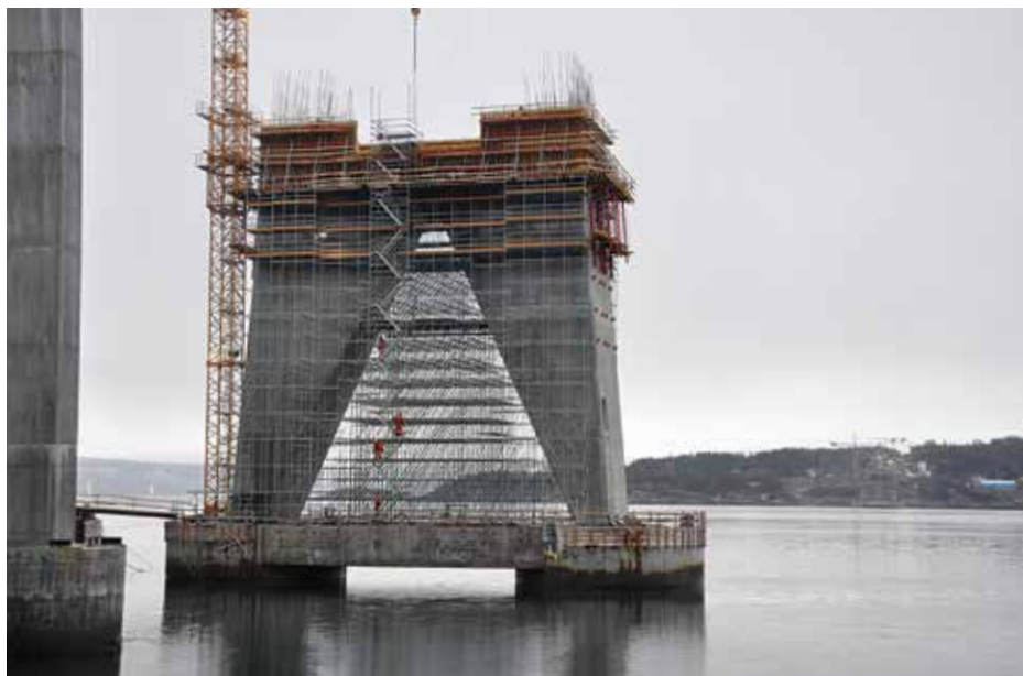
TO BRUTÅRN: 1145 meter skiller de to brutårnene som er under bygging ved Narvik.
