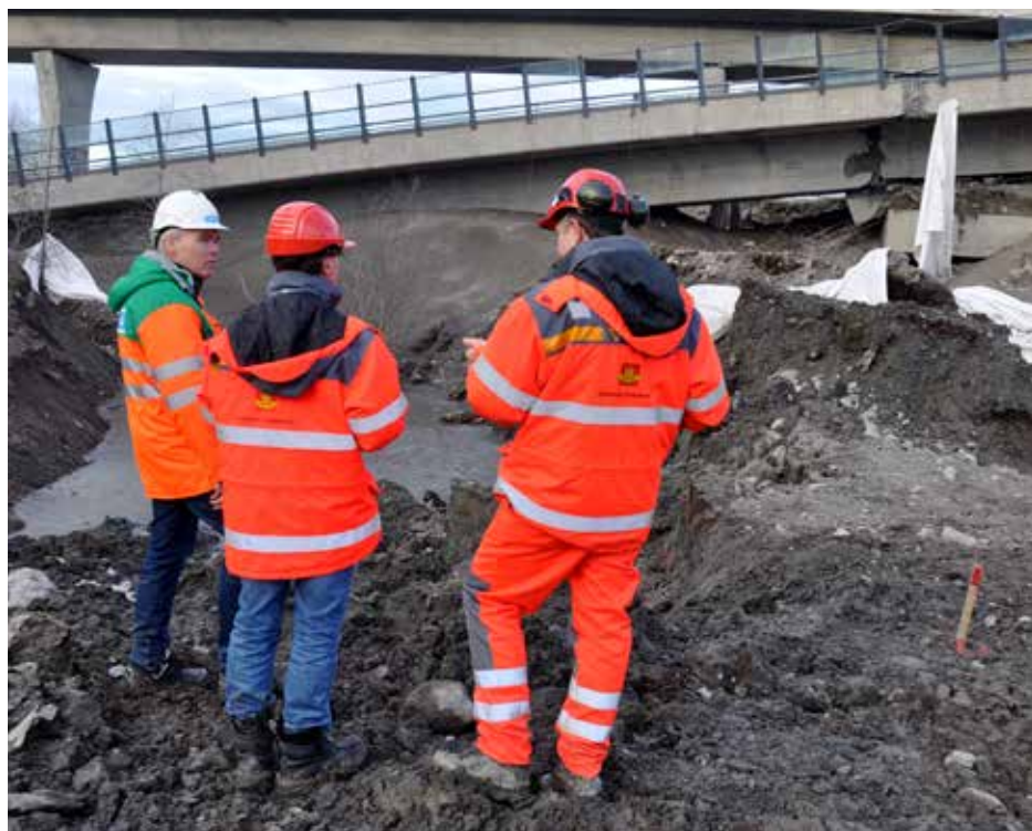
KONTROLL: Ekspertene fra Norges Geotekniske Institutt og Statens vegvesen kontrollerte området nøye rett etter og et døgn etter sprengningen.
