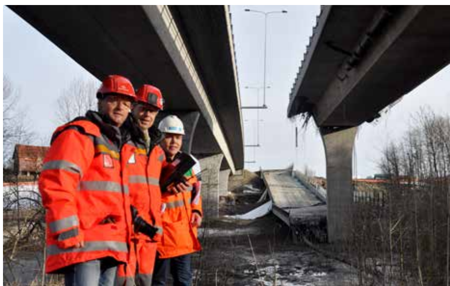
DE FØRSTE: Brudirektør Børre Stensvold, byggeleder Bjørn Gjeldsås og Inge Solberg fra Rambøll var de første inn for å kontrollere brukonstruksjonene etter nedsprenningen.
