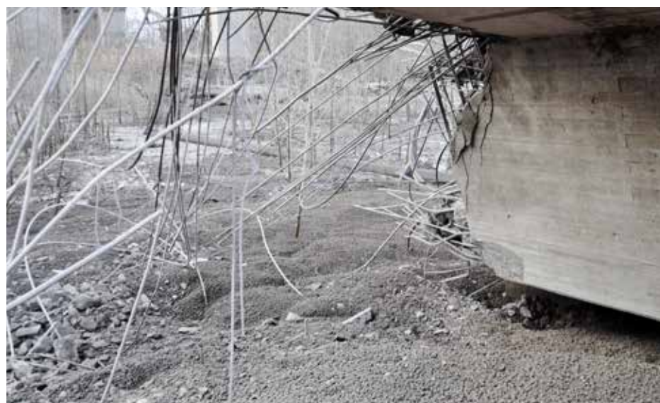
LECA-KULER: Brua falt ned på 2000 kubikkmeter Leca-kuler, og dermed ble det ikke et støt mot bakken som kunne utløse nye ras.
