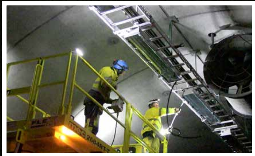
NATTARBEID: På nattestid er entreprenøren TeamBane i gang med å strekke ny kabel i Nordbyttunnelen på E6 syd for Oslo. Prosjektleder Thomas Kalleberg (til venstre) hadde nylig besøk av regionvegsjef Per Morten Lund og HMS-kordinator John Ivar Nelson. (Foto: Øystein Skotte)
