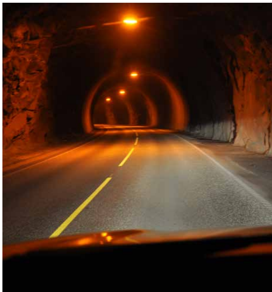
GAMMEL STANDARD: Mange av de eldste tunnelene er mørke, etter oppgraderingen blir de lysere og får mer sikkerhetsutstyr.
