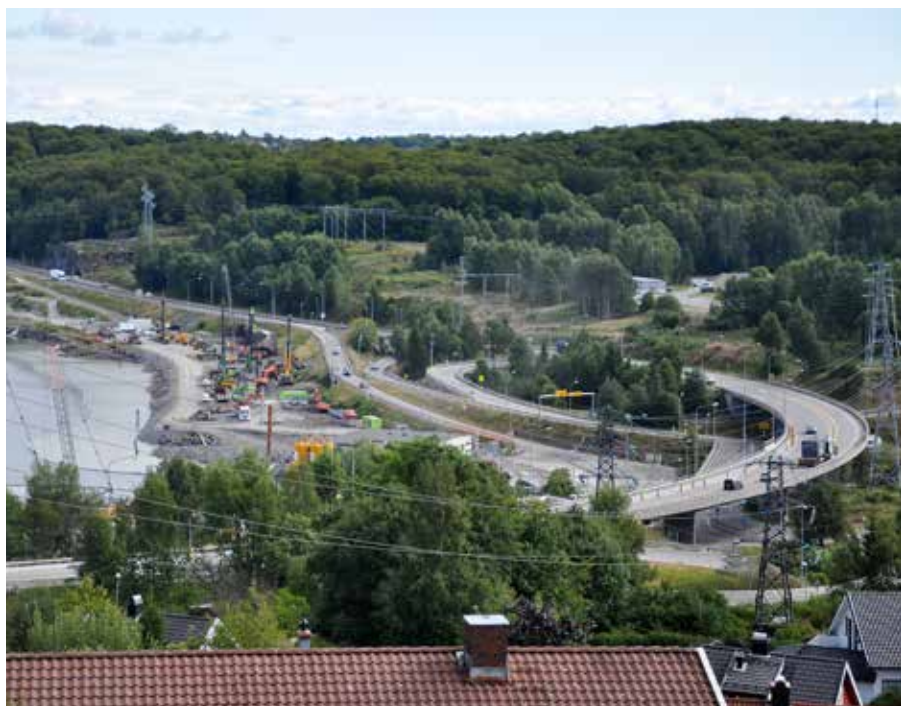
OVERSIKT: I dette området i sørenden av Farrisvannet bygges det en ny E18-bru.
