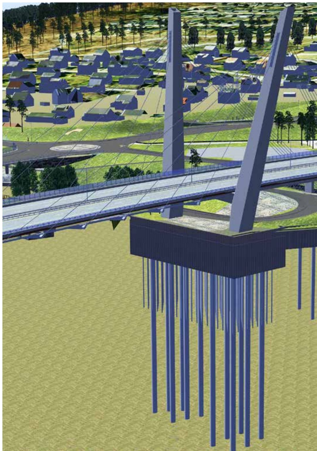
DYPE: Fundamentene til brutårnene på Farrisbrua går dypere i grunnen enn høyden på brutårna. (Illustrasjon R
