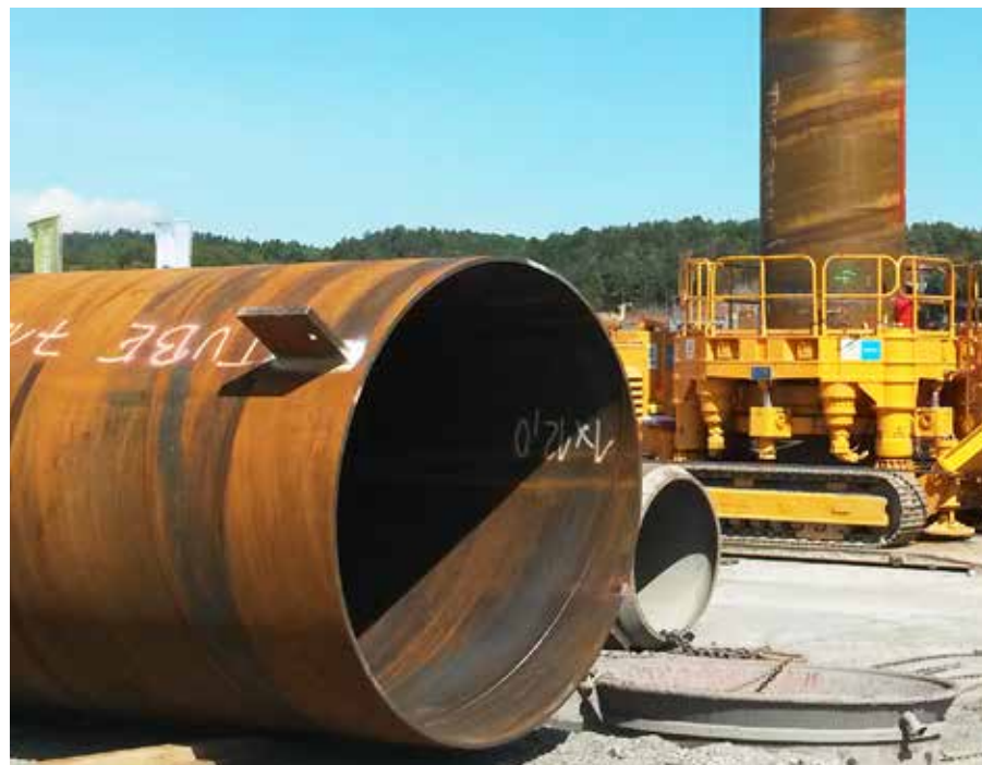
STÅLRØR: Det er store dimensjoner på Farrisbrua.
