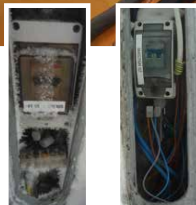
LØST GÅTEN: Vidar Sandquist fant løsningen på kondensproblemet i koblingsboksen i lysstolpene.
