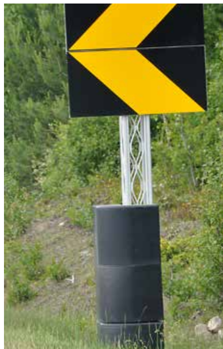
POLSTRING: Slike støtabsorberende puter er det montert mange av på stolper langs fv 32
