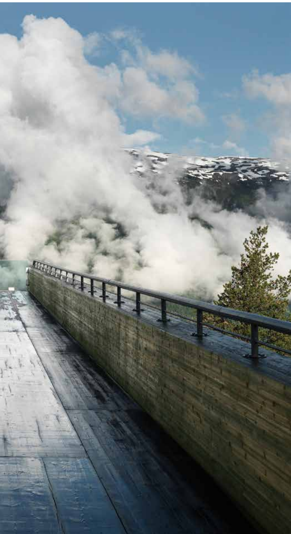
en ny måte: Utsiktsrampa Stegastein svever 30 meter ut over furutoppene 640 meter over Aurlandsfjorden.
