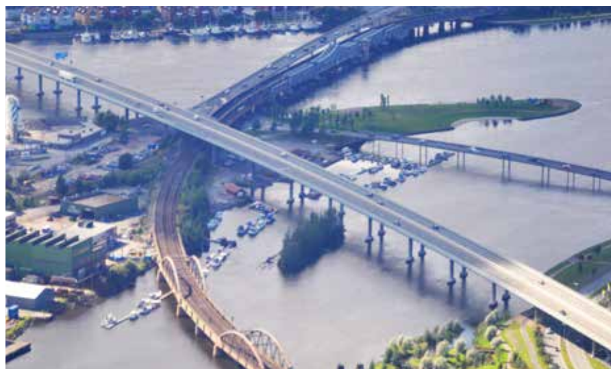
E18 MOTORVEGBRUA I DRAMMEN: Del av Vegpakke Drammen som ble sterkt forsinket og aldri fullført
