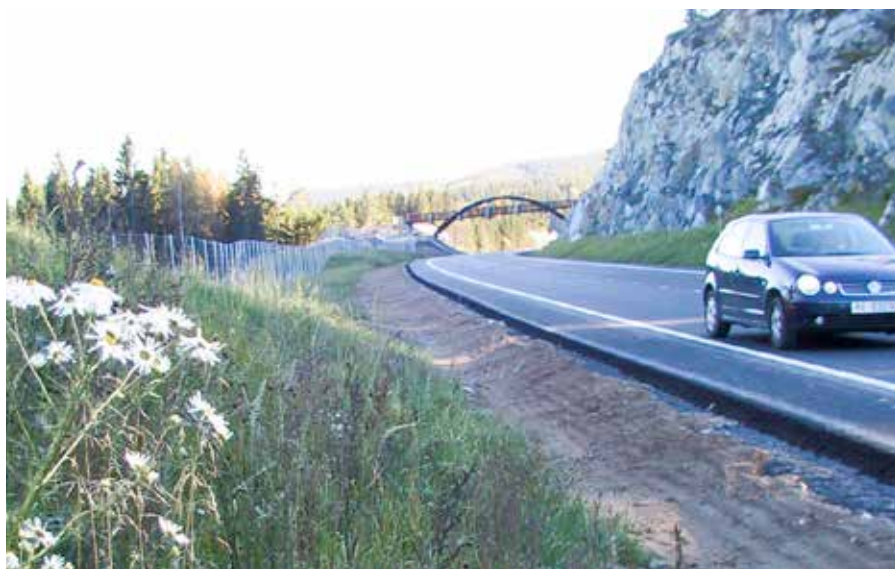
TIL AVKLARING: Samferdselsdepartementet skal nå avklare om denne E18-strekningen, ferdigstilt i 1998, skal utvides til to/tre- eller firefeltsveg med fysisk midtdeler.
