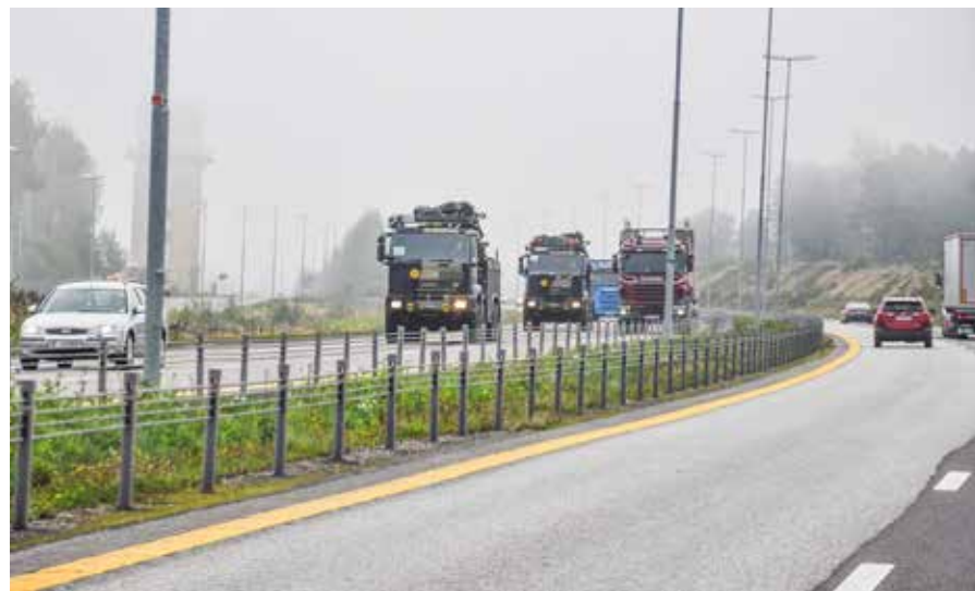
INGEN DØDSULYKKER: Dødsulykkene er fjernet fra E6 i Østfold etter at den fikk et fysisk skille mellom kjøreretningene og to kjørefelt i hver retning.
