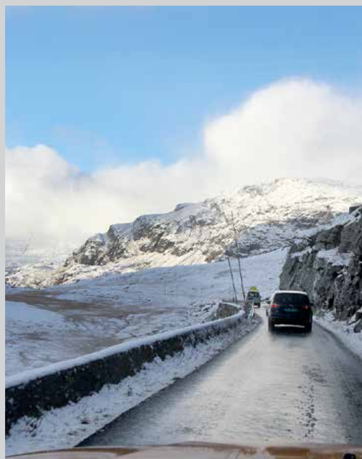
OMKJØRING: Den gamle veggen kommer til sin rett når tunnelen er stengt for rehabilitering.
