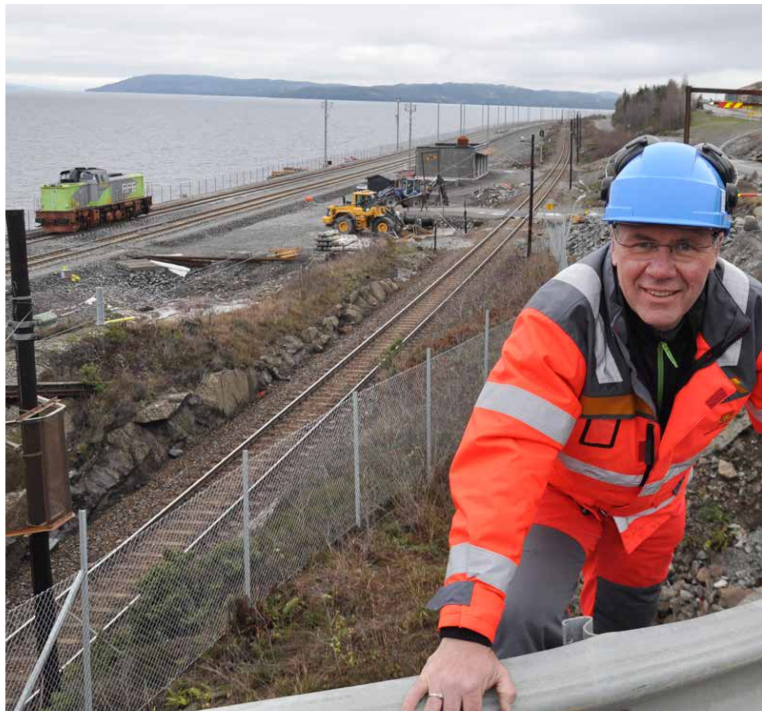
2,5 ÅR: Prosjektleder Taale Stensbye har byttet fra rød til en sikrere blå hjelm i løpet av anleggsperioden. Bak han er det skjedd store landskapsforandringer.
