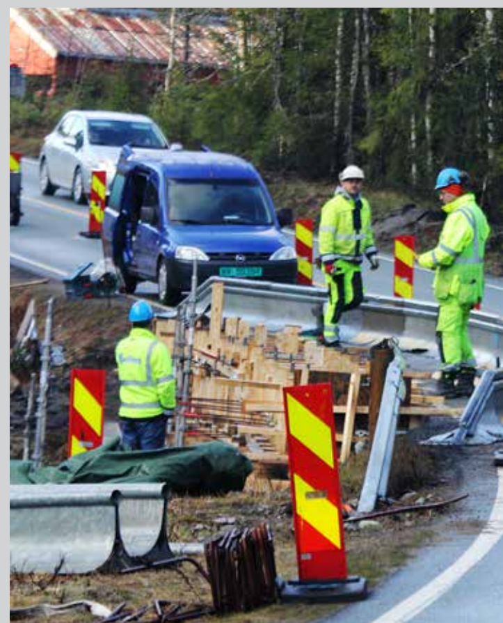
BRUARBEID: Et arbeidslag fra Ypsilon rehabiliterer Ofte bru. Betongen er s...
