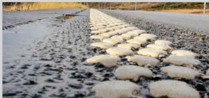
DRÅPER: Vegkanten avslører at den hvite stripa er frest ned og malingen ligner diamantdråper som reflekterer tilbake selv i grått og vått vær.
