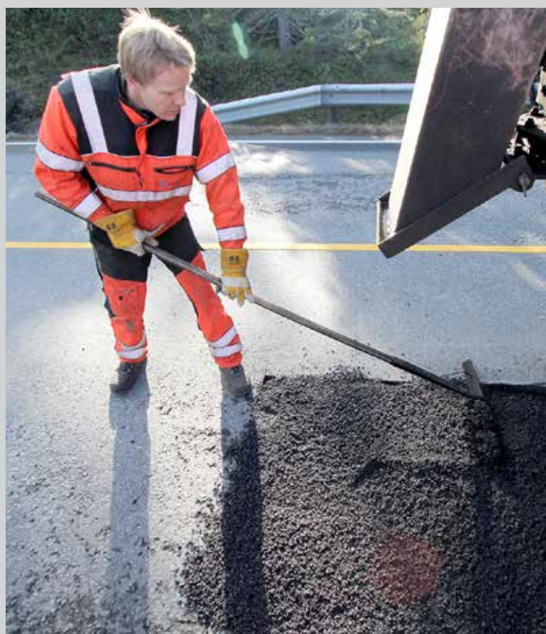
ASFALT: Olav Kai Skolås fra Opedal Drift reparerer småskader på E134 i Vinje.
