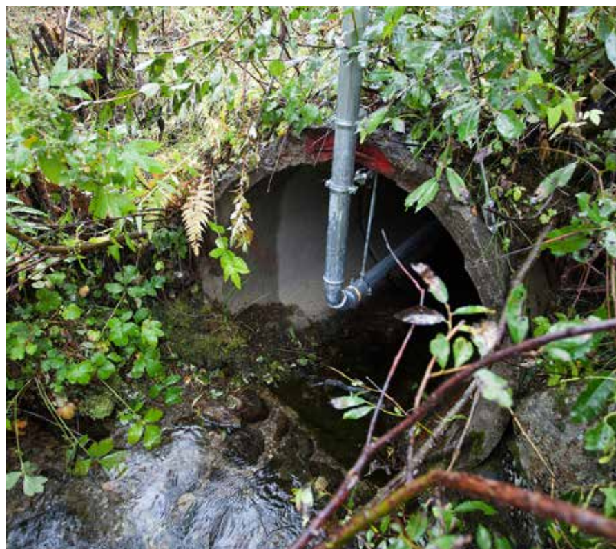
SENTRALT: Røret kan henges opp i renna, både i toppen eller sentralt, eller det kan ligge på bunnen. Alle tre typene prøves for å se hva som fungerer best. Her er røret montert sentralt.
