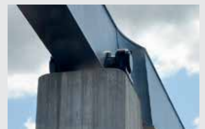
KLAFFEBRU: Den 54 meter lange balansearmen henger 19 meter over kjørebanelen og veier hele 615 tonn.
