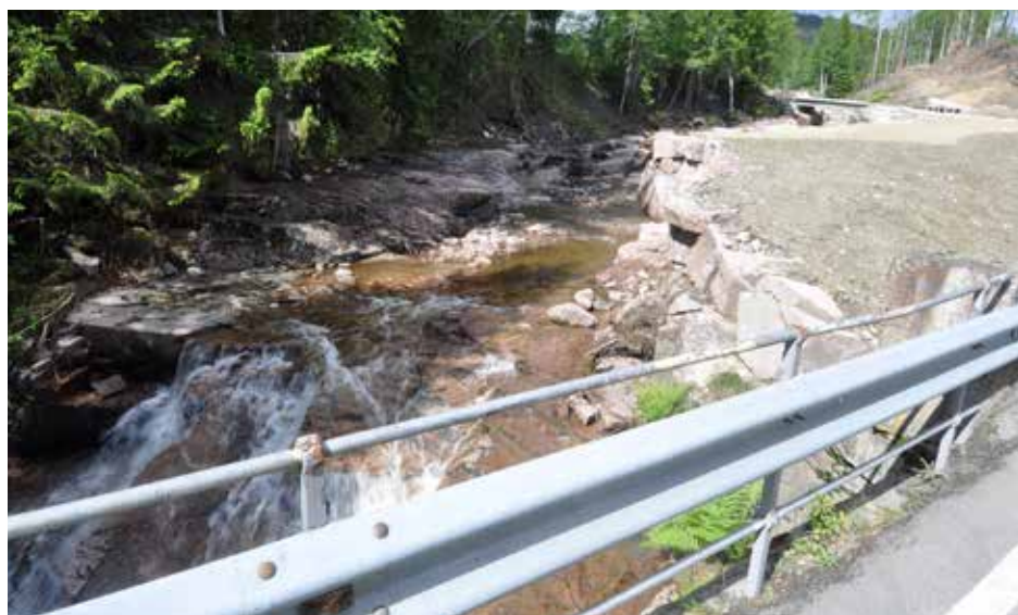
SIKRET: Fjell er sprengt vekk for at Vesleelva i Øvre Eiker ikke skal ta nytt løp ved ny flom.
