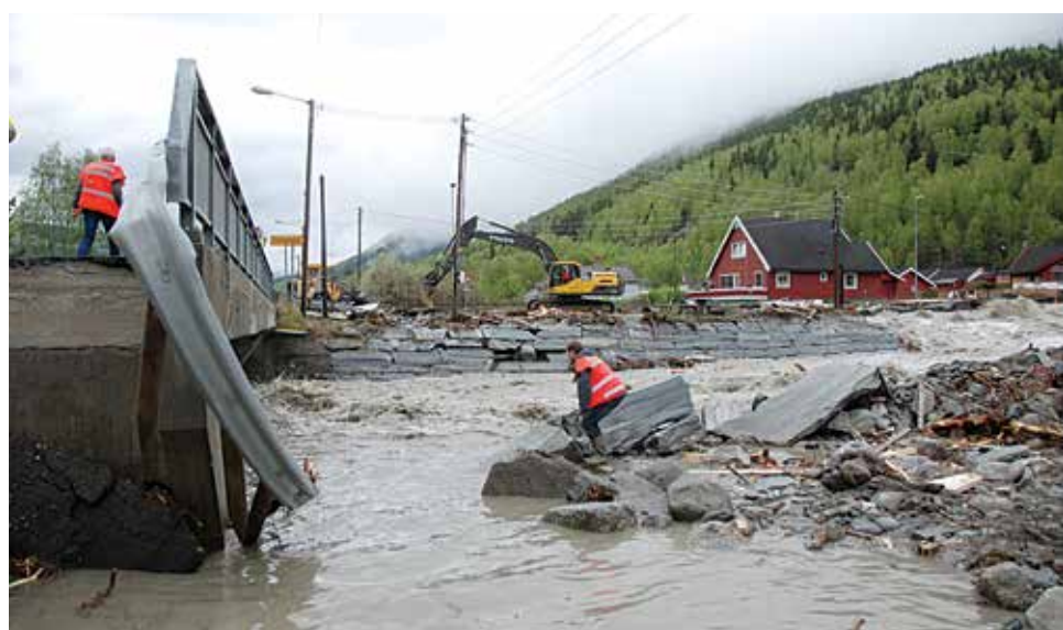
KVAM: Bruingeniør Andes Brenne fra region øst undersøker brua på E6.
