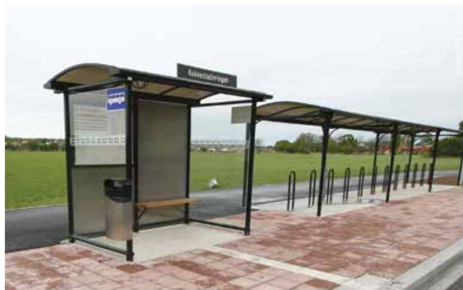
FOR ALLE: Universell utforming dreier seg om mer enn «bare den ene rullestolbrukeren», skriver artikkelforfatteren. For eksempel er en holdeplass som er universelt utformet, slik som denne ved Glommaringen i Østfold, gir muligheter for alle mennesker til å kunne ta offentlig transport. (Foto: Amund Hareland)
