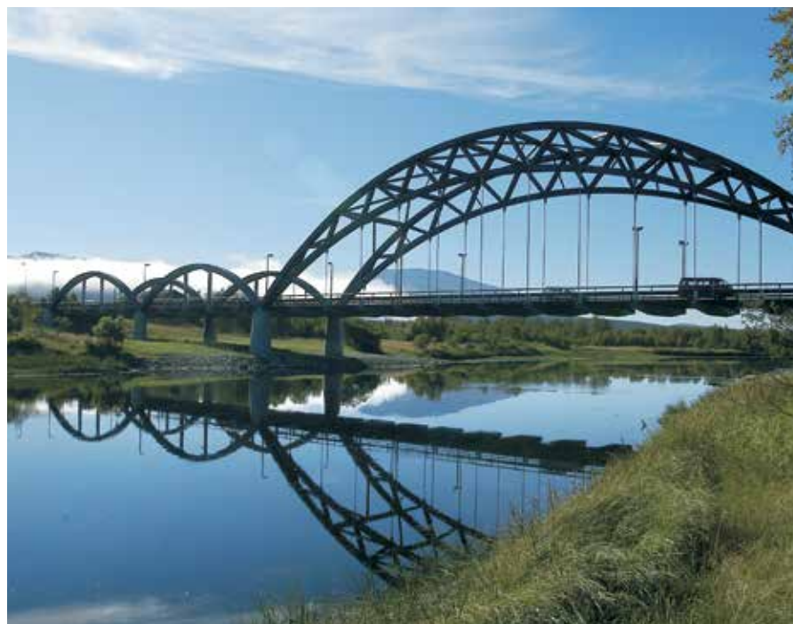
IMPREGNERES: De fleste av landets trebruer impregneres med kreosot. Her er Tynset bru.
