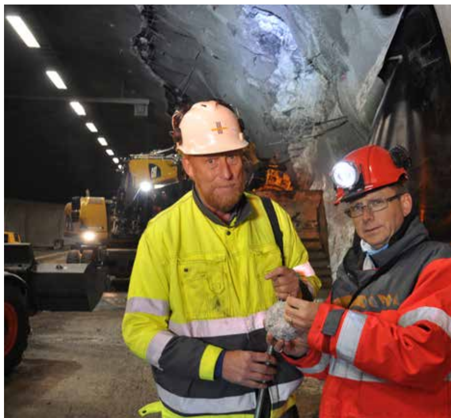
SIKRET: Ingeniørgeolog Asbjørn Halvorsen i Multiconsult og teknisk byggeleder Per Lyder Nyland i Statens vegvesen sikret Eidettunnelen etter at svelleire skapte problemer.
