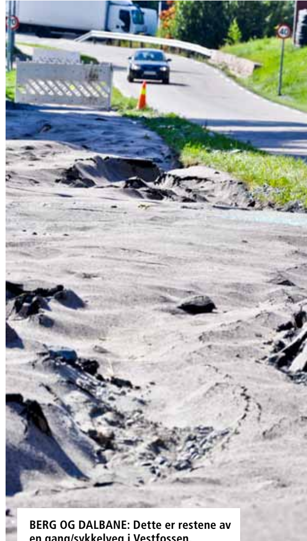
SPERRET: Nesbekken i Sigdal delte fv. 287 i to sør for Nerstad.
