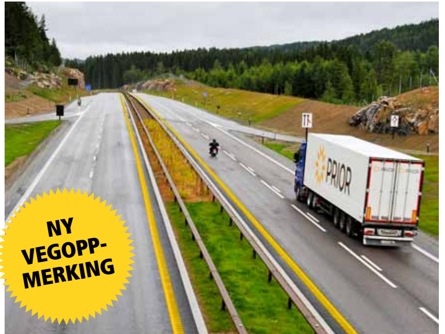
GULT I MIDTEN: Nå skal det bli gul vegoppmerking inn mot rekkverk, midtdelere og trafikkøyer. De gule stripene i dette bildet er montert inn.
