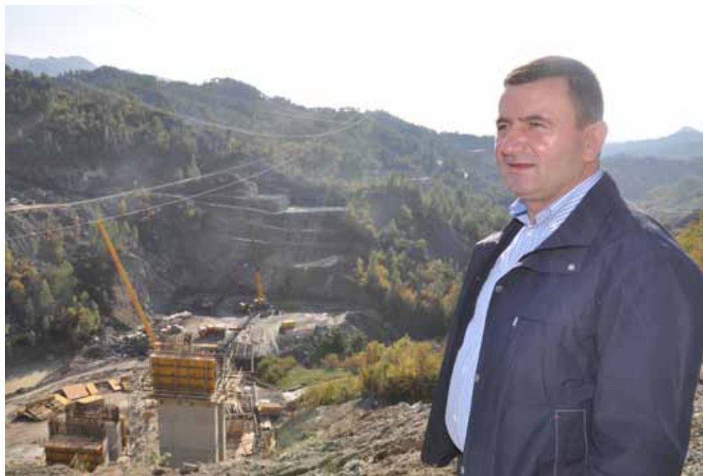
▲ KORT BYGGETID: – Neste sommer er det bru og 28 meter bred motorveg her, sier prosjektleder Skender Cota som bygger 27 kilometer firefeltsveg mellom Tirana og Elbasan.
