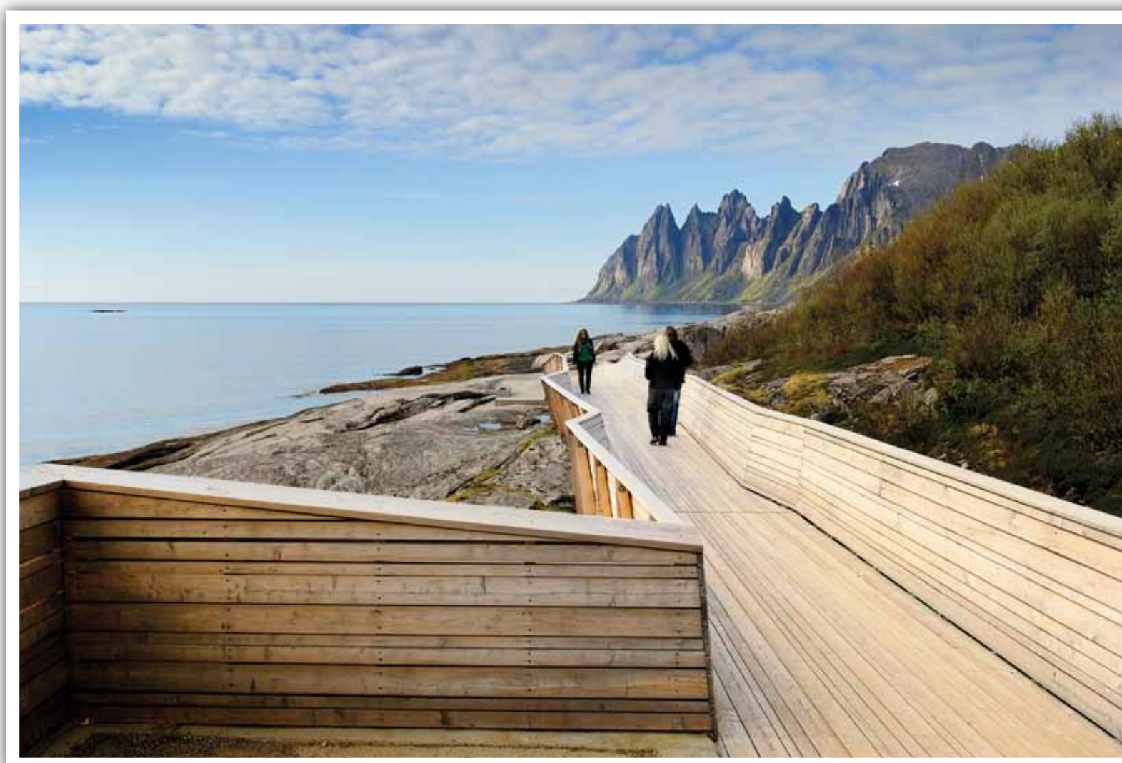
Tungeneset rasteplass og utsiktspunkt, langs Nasjonal turistveg Senja. Arkitekt: Code arkitektur as; Marte Danbolt. Foto: Jarle Wæhler / Statens vegvesen
