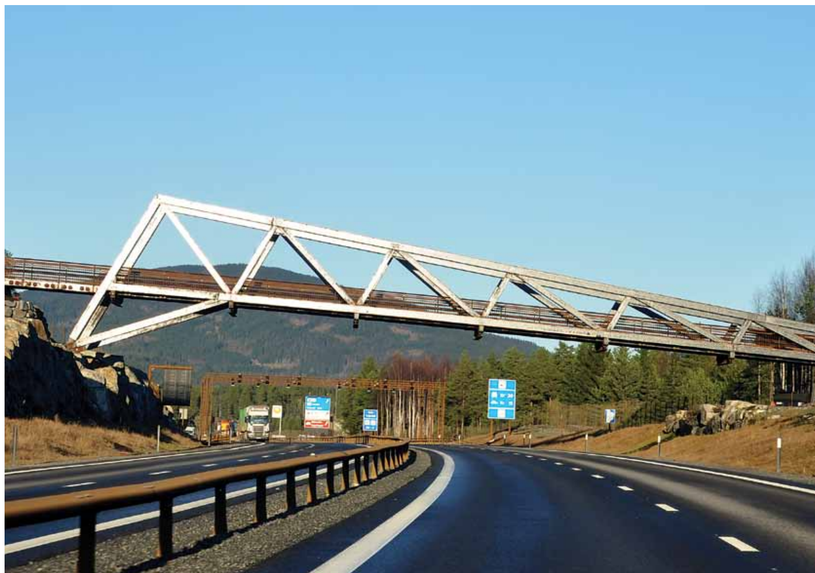
FJELL-LEET BRU: En usymmetrisk konstruksjon for hellende terreng
