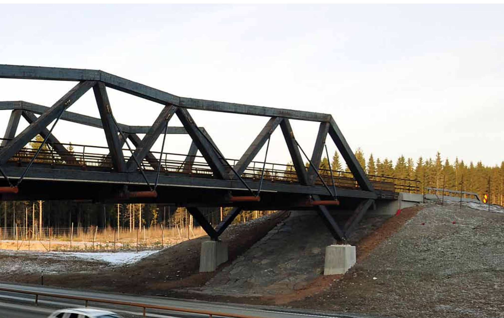
FJELL-LEET BRU: En usymmetrisk konstruksjon for hellende terreng
