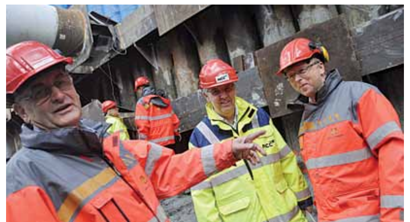
HOLDER TETT: Geotekniker Torgeir Haugen arbeider for entreprenøren NCC, Sigbjørn Rønning fra Multiconsult for Statens vegvesen. Sammen med Anders Beitnes jobber de for å holde byggegroppa tett og stabil inntil betongtunnelen er ferdig og kan fylles over.
