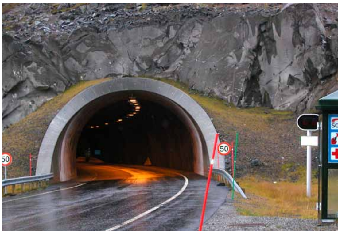
Honningsvågtunnelen: Den lengste av tunnelene i Fatimaprosjektet på hele 6,9 kilometer. (Foto: Giselle Jensen)
