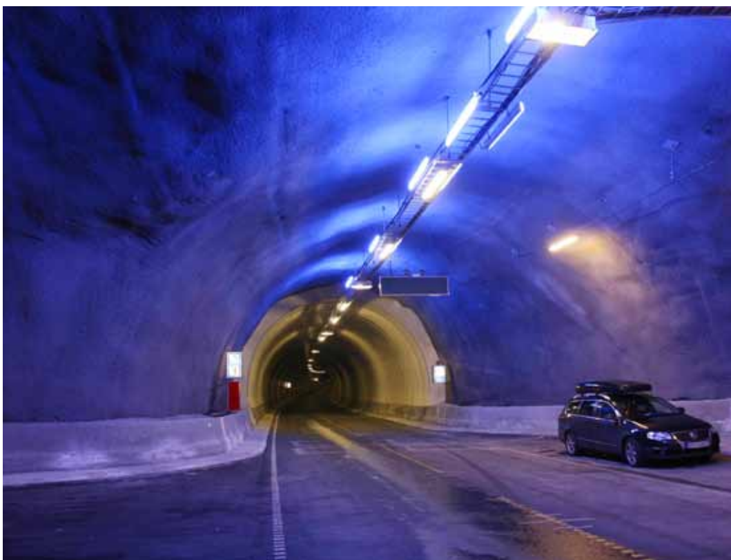
Kontakt: For mange gir den direkte kontakten med omverda gjennom veg ei psykisk styrke. Bilete øverst er frå åpning av riksveganlegget Skibotn - Løkvoll i 1974, siste etappe for å skaffe fergefri E6 i Troms. Bilete under er frå Eiksundtunnelen som binder Hareidlandet saman med fastlandet på Sunnmøre. (Foto: Statens vegvesen)
