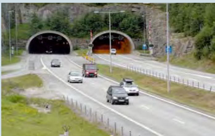
Tunnelutbedring: E18 Hanekleivtunnelen i Sande i Vestfold må oppgraderes på ny i 2014. (Foto: Kjell Wold)
