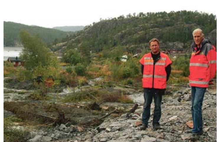
Raset startet i bakkant, inn mot fjellet bak prosjektleder Kolbjørn Engen (og byggeleder André M. Aglen.) (Foto: Håkon Aurlien)
