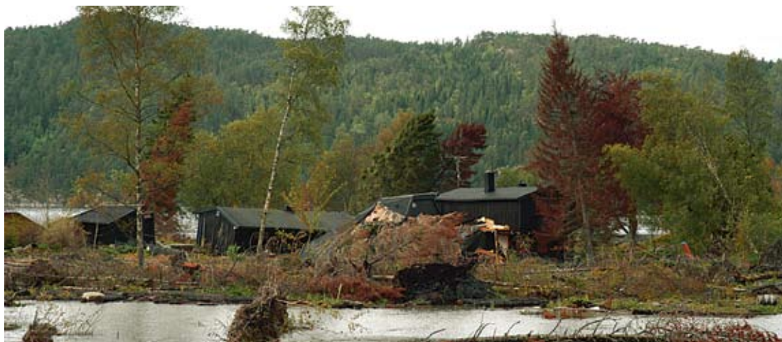
Et halvt år etter leirraset i Kattmarka utenfor Namsos flyter fortsatt husrester i vannoverflaten (Foto: Håkon Aurlien)
