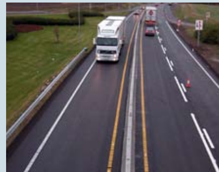
Betong : Midtrekkverk i betong har gitt gode erfaringer på E18 i Telemark. (Foto: Kjell Wold)
