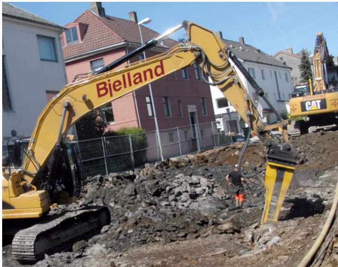
Dunk – dunk: Maskinene meisler fjellgrunnen gjennom gateløpet. (Foto: Geir Brekke)
