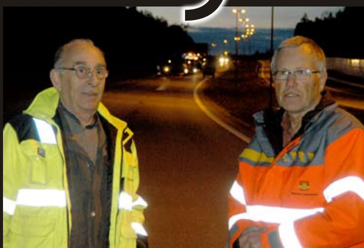
Følger med: Driftsleder Hans Jacob Henaug fra Lemminkäinen Norge AS og Olaf Schmedling, byggeleder for asfalt Statens vegvesen, følger med under asfalteringen. (Foto: Håkon Aurlien)
