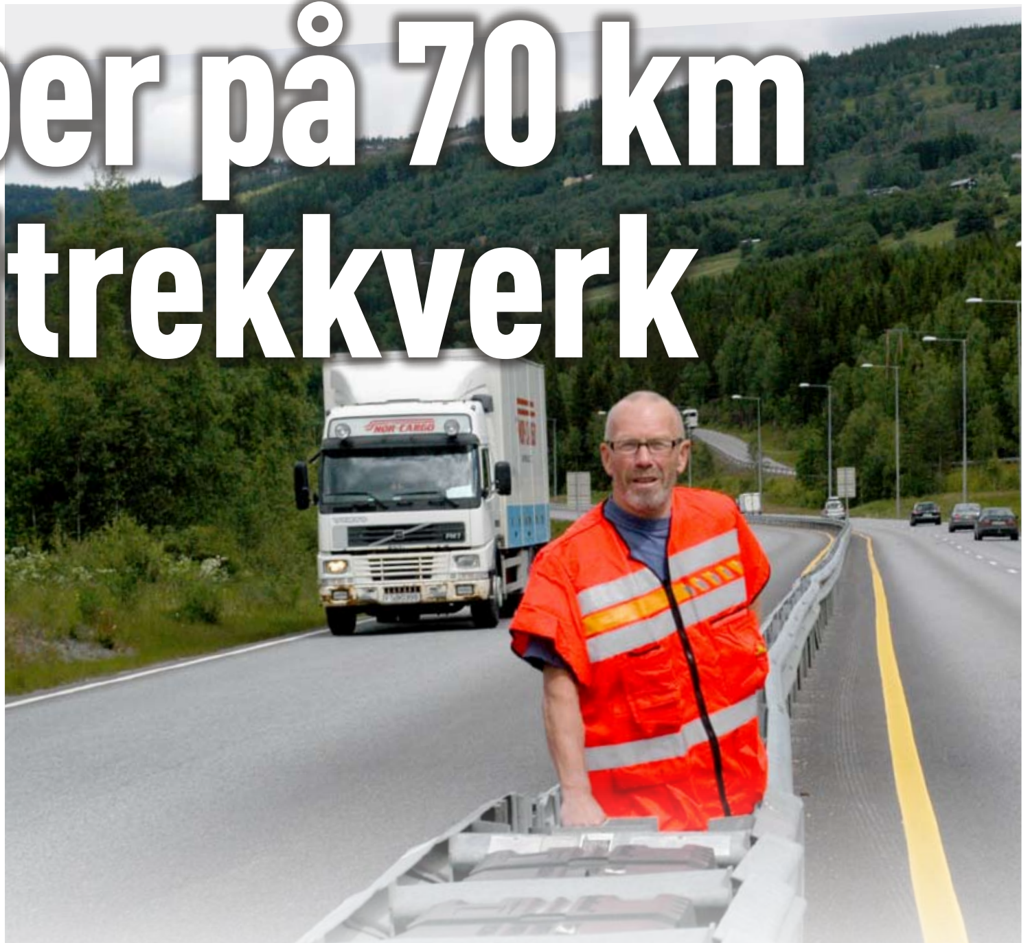
Hindrer møteulykker: E6-prosjektleder Torbjørn Moastuen skal bygge 70 km midtrekkverk gjennom Gudbrandsdalen. (Foto: Håkon Aurlien)
