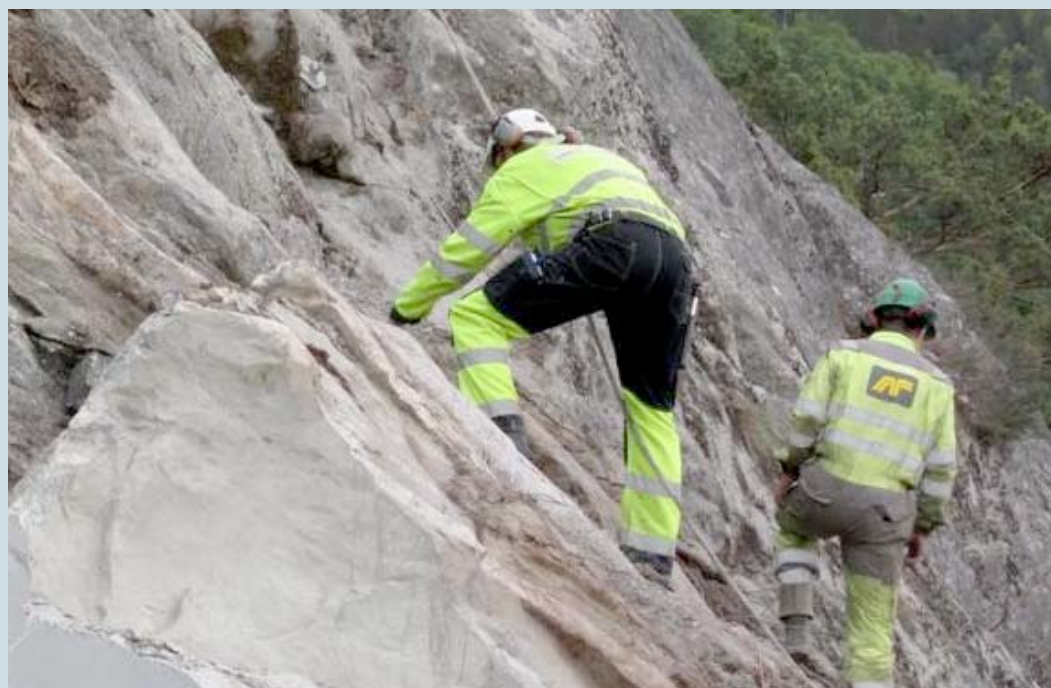
Bratt tunnel: Kontrollarbeid i samband med bygging av tunnel mellom Hardangerbrua og Vallaviktunnelen. (Foto: Eivind Kollé)
