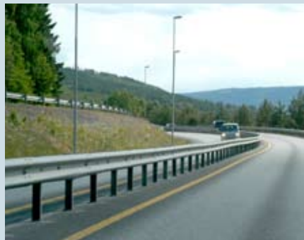
Stål : Midtrekkverk i stål er prøvd ut på E6 ved Hunderfossen i Oppland. (Foto: Håkon Aurlien)
