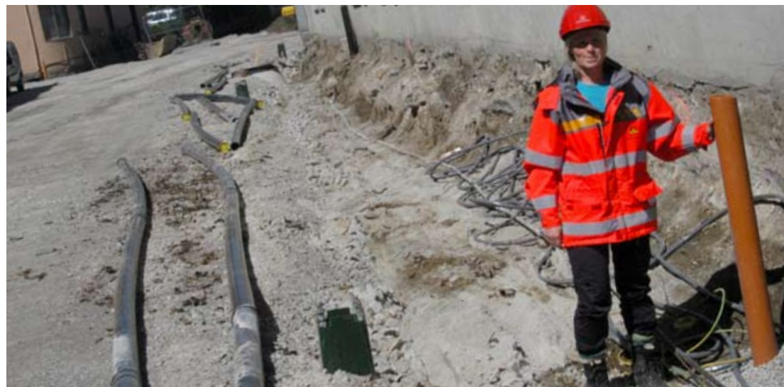
Kabel-kabal: Prosjektleder Nidunn Sandvik Eiterjord i Statens vegvesen har hatt mye kommunale ledninger å håndtere i gatefornyelsen. (Foto: Geir Brekke)
