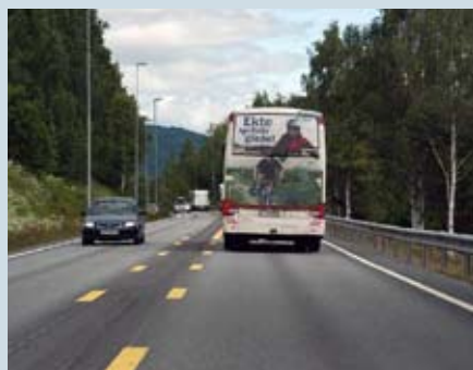
Rumlefelt : Striplet midtoppmerking gir økt avstand på E6 langs Mjøsa. Her gjøres et forsøk med en ny type frest rumlefelt som varslar føreren hvis vedkommende kommer inn på midtfeltet. (Foto: Håkon Aurlien)
