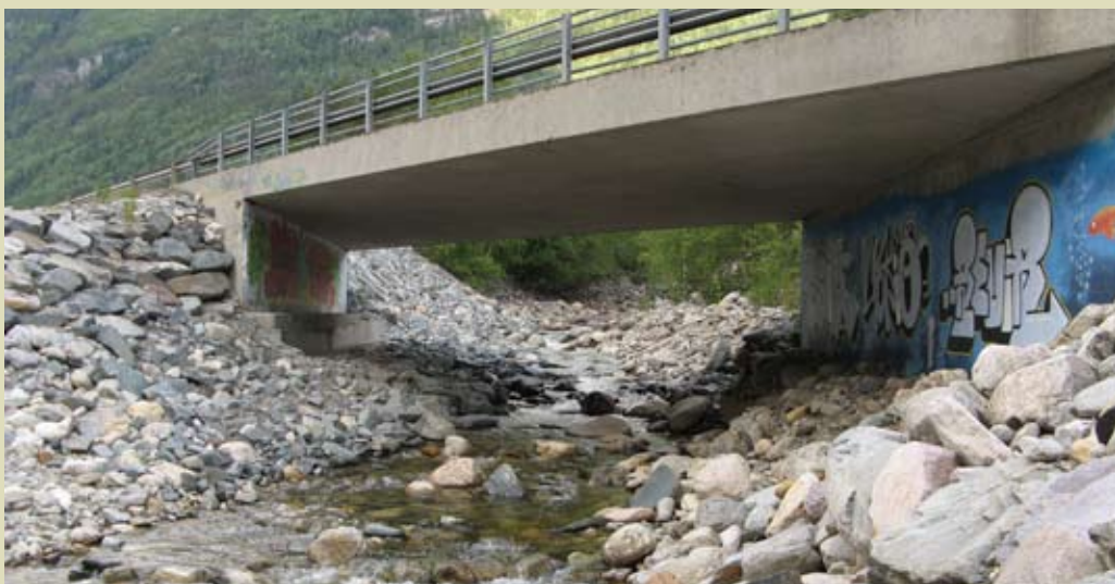
Sikres mot flom: På Middøla bru og Bitu bru i Telemark skal det testes ut hvordan en kan sikre bedre mot flom. Her et flom- og erosjonsutsatt elveløp ved Middøla bru. (Foto: Hans Olav Hagen).
