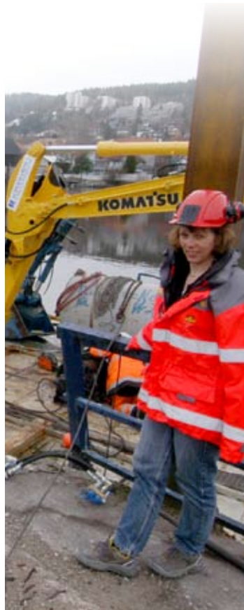
Flomsikring: Byggeleder Grete Tvedt i Statens vegvesen ved Øvre Sund bru som erosjons- og flomsikres for 15 millioner kroner. (Foto: Kjell Wold).
