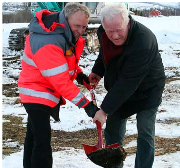
Styreleder i Ryaforbindingen, Erlend Rian (t.h.) og regionvegssjef Torbjørn Naimak fikk æren av å ta det første spadetaket. (Foto: Lisa Sundstrøm)
