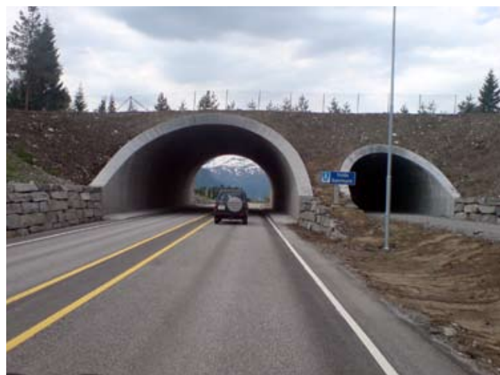
Fri passasje: Dyrespor viser at den nye viltovergangen på riksveg 653 Eiksundsambandet blir mye brukt. (Foto: Ulf Lucassen).
