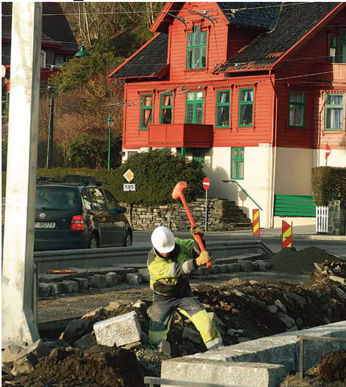
Bedre bussing: Anleggsfolkene er i gang med bygging av nye kollektivfelt på rv. 585 i Bergen. (Foto: Geir Brekke)
