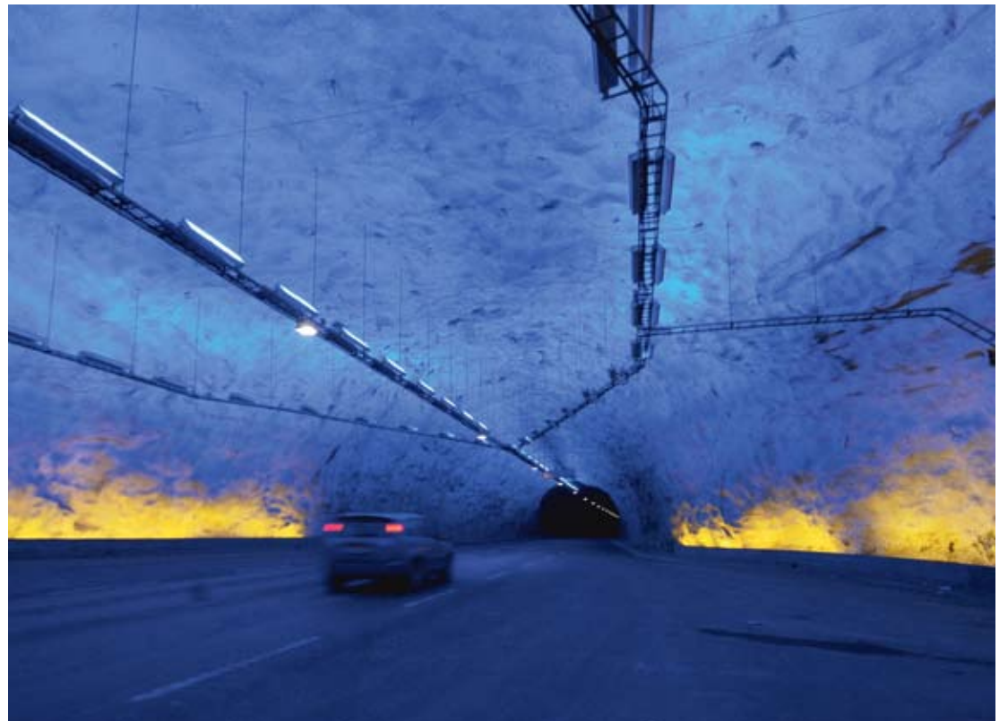
Lengst: Verdens lengste vegtunnel, Lærdalstunnelen, med sine spektakulære lysbesatte pusterom, er bygget av Statens vegvesen. (Arkivfoto: Geir Brekke)
