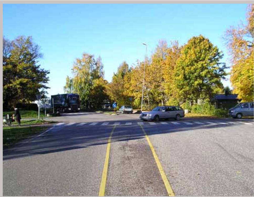
Før: Dødskrysset før utbedring.
