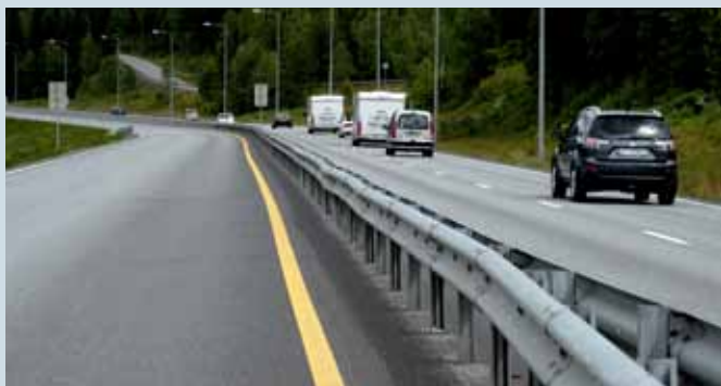
Midtrekkverk: Middeler i form av midtrekkverk ved Hunderfossen på E6 i Gudbrandsdalen. (Arkivfoto: Håkon Aurlien)
