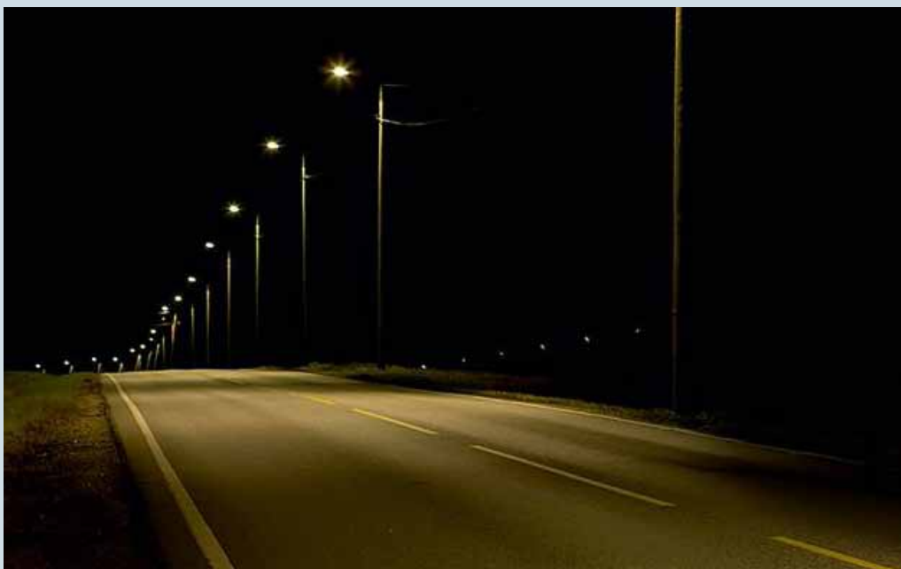
1: Så lenge det ikke er eller biler eller andre kjøretøy, er belysningen dempet. (Alle foto fra Comlight AS)
