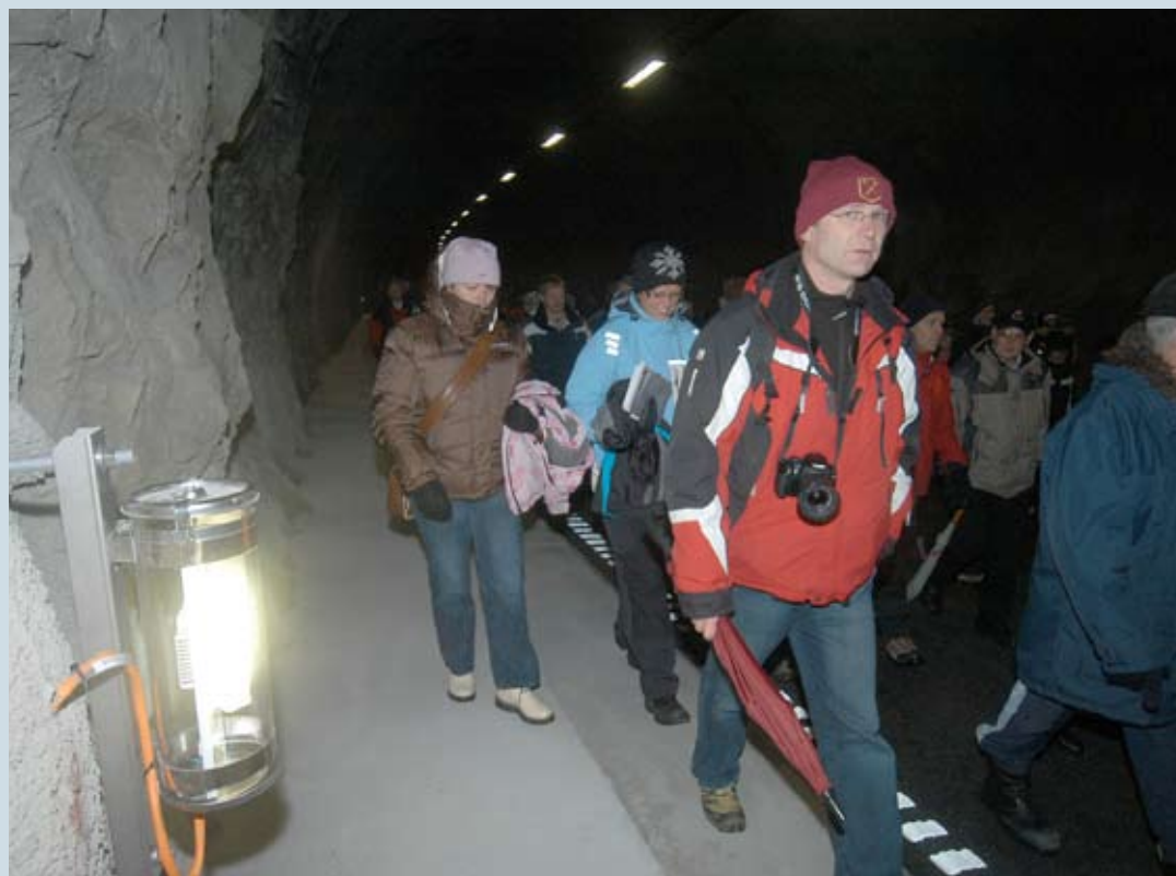
Lys i tunnelen: Evakueringslysa er på plass i rv. 13 Myrkdalstunnelen. (Foto: Geir Brekke)
