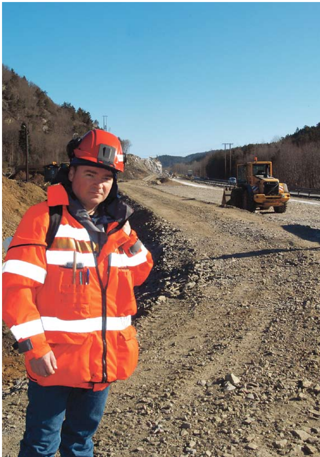
Midtrekkverk: Nesten to kilometer av denne ulykkestrekningen på E39 i Søgne får nå midtrekkverk, sier byggeleder Martin Folkestad i Statens vegvesen. (Foto: Kjell Wold)
