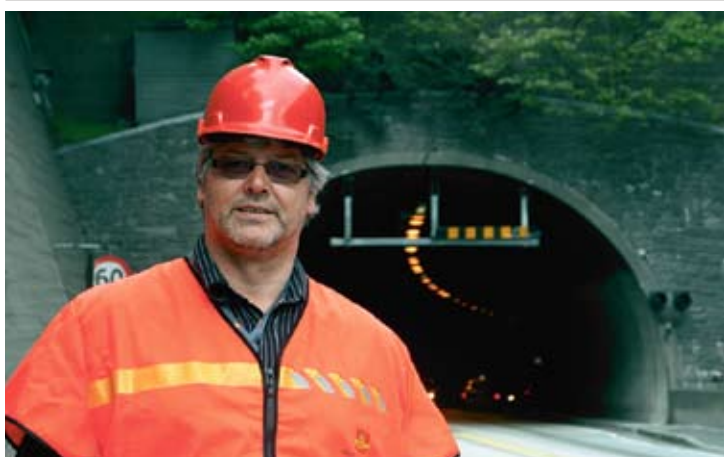
Brann er best: Løvstakktunnelen i Bergen er et eksempel på en byttunnel som kunne være aktuell for brann-deteksjon, sier Tor Tybring Aralt i Statens vegvesen. (Foto: Geir Brekke)
