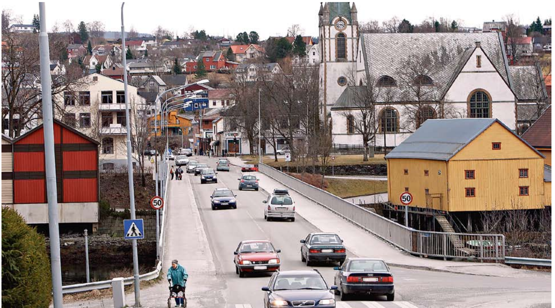
Velbrukt: Rundt 6 000 kjøretøy passerer daglig over Sund bru i Levanger. (Foto: Leif Arne Holme)
