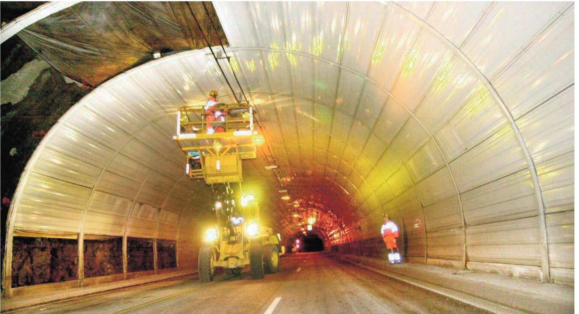
Unngår stenging: Platehvelvet i Freifjordtunnelen ble demontert i 2006. Distriktsleder Jan Arild Johansen er glad for at Vegvesenet unngår å stenge tunnelen helt når den skal gjennom en større rehabilitering. (Arkivfoto: Ole T. Strand)
