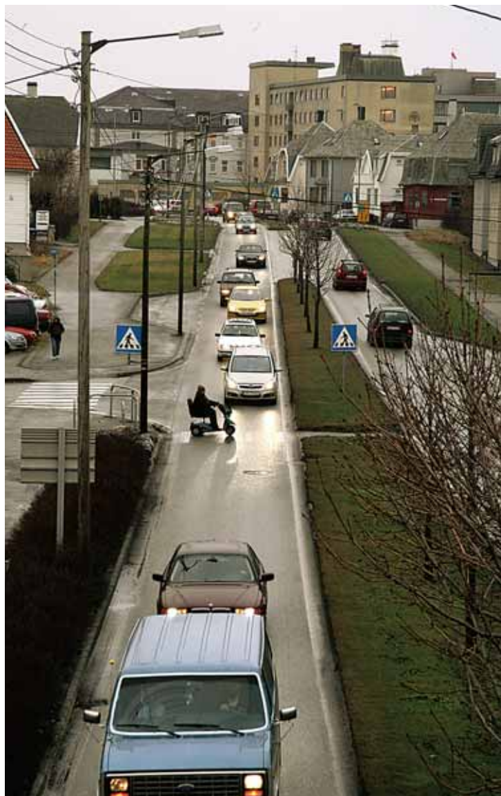
To felt gir kø: Rv. 47 Karmsundgata har en døgntrafikk på 28 000, som er svært høyt for en tofeltsveg. (Foto: Geir Brekke)
