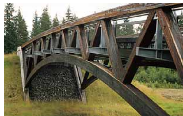
Skubbergsenga bru: Trebruene hadde en renesanse i nitti-åra. Denne er bygd i 1997 med en tradisjonell teknikk med moderne uttrykk. (Foto: Trond Arne Stensby)
