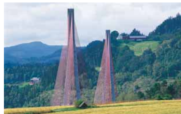
Skarnsundbrua: Ligger innerst i Trondheimsfjorden og ble bygd i 1991. Den er blant annet fredet på grunn av identitetsverdien, arkitektonisk verdi og estetisk verdi. (Foto: Johan Brun)
