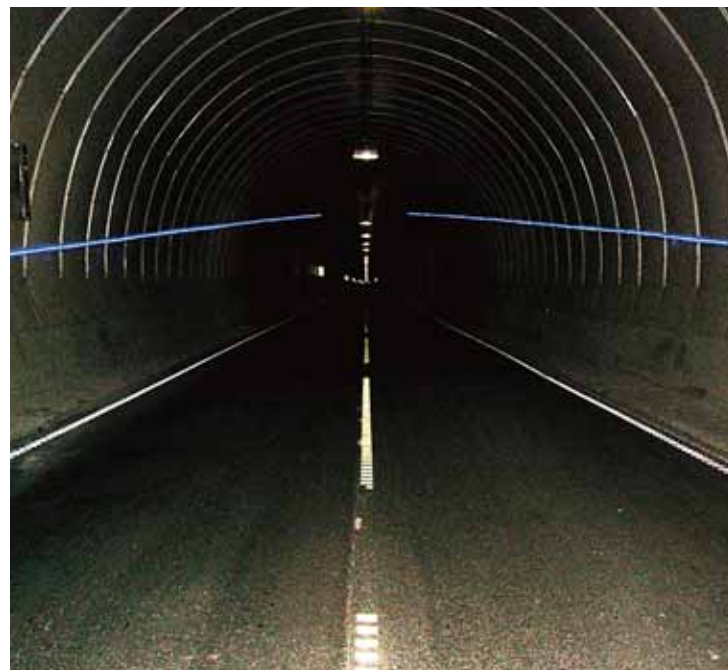
Ny verdensrekord: 23. februar åpner verdens dypeste undersjøiske tunnel. (Foto: Statens vegvesen)
