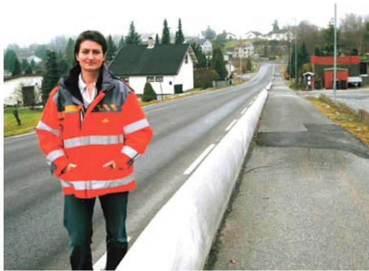
Rekkverk: – Her er 750 meter nytt betongrekkverk montert for å skille veg fra gang- og sykkelbane, sier Hanne Løver Thon i Statens vegvesen. (Foto: Kjell Wold)
