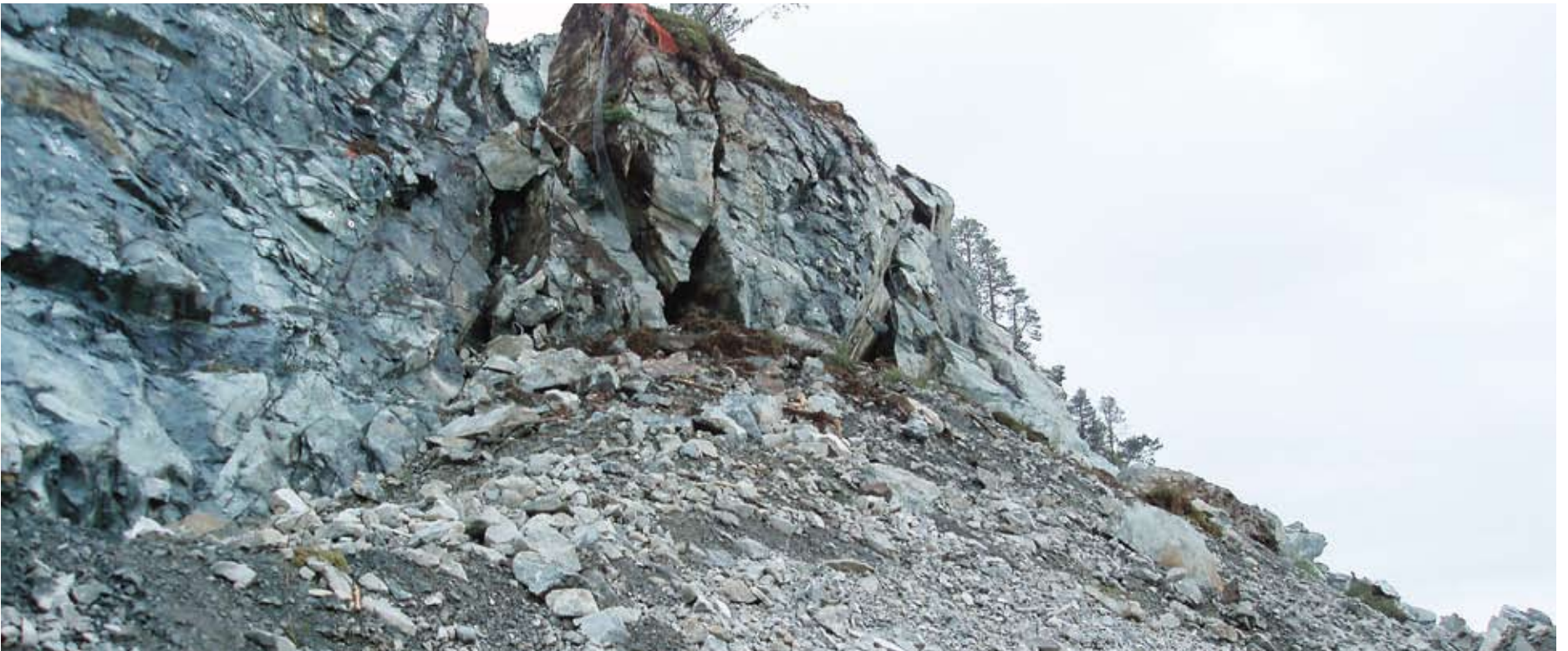
Løsberga: Betyr ikke "løst berg". Opphavet til navnet er gården Lø og har ikke noe med bergmassekvaliteten å gjøre. Årsaken til problemene er grovblokkete berg med slepper som ikke lot seg kartlegge før raset gikk 30. juni. (Foto: E6 Steinkjærprosjektet)
