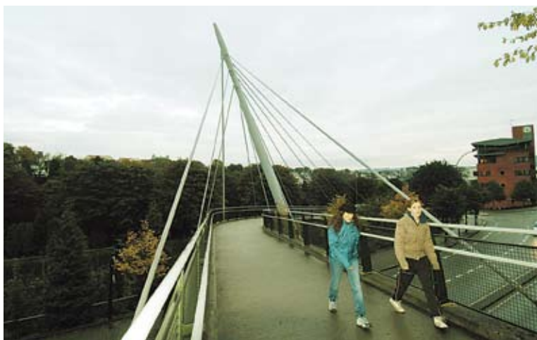
Gangbrua i Lagårdsvegen i Stavanger. (Foto: Geir Brekke)
