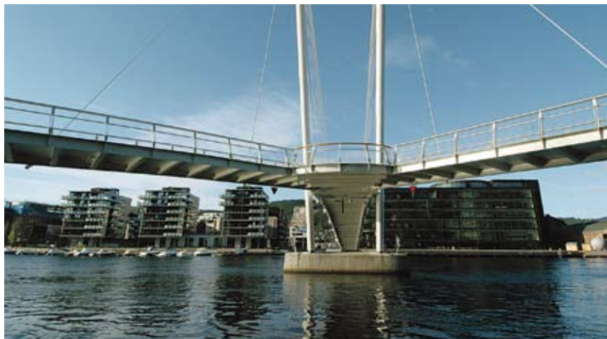
Ypsilon gangbru i Drammen (Foto: Kjell Wold)
