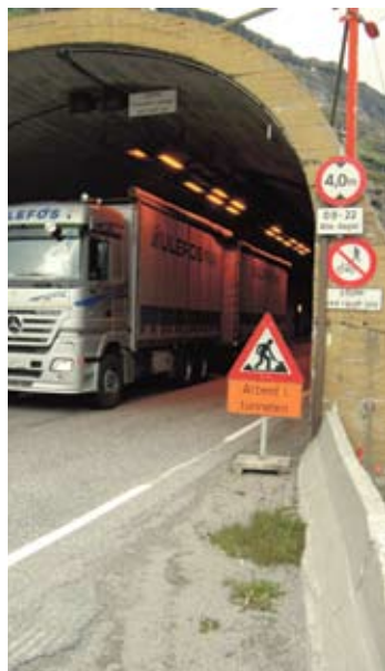
Haukelitunnelen: Eksempel på veldig gammel tunnel på E134 som nå rehabiliteres. (Foto: Kjell Wold)
