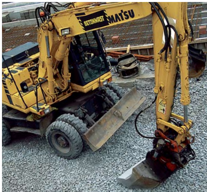
Mindre gategraving: Et nytt system skal koordinere alle graveplaner i Oslo. Dermed blir det mindre graving.
