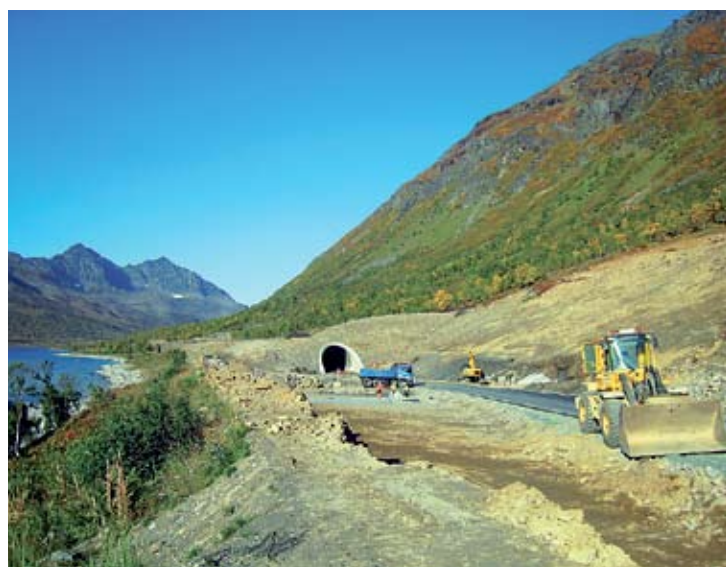
Snart ferdig: Rasoverbygget kommer til å bli lite synlig når vegetasjonen får skikkelig tak. (Foto: Eivind Berglund)
